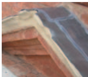
Dettaglio della protezione dei timpani in arenaria
