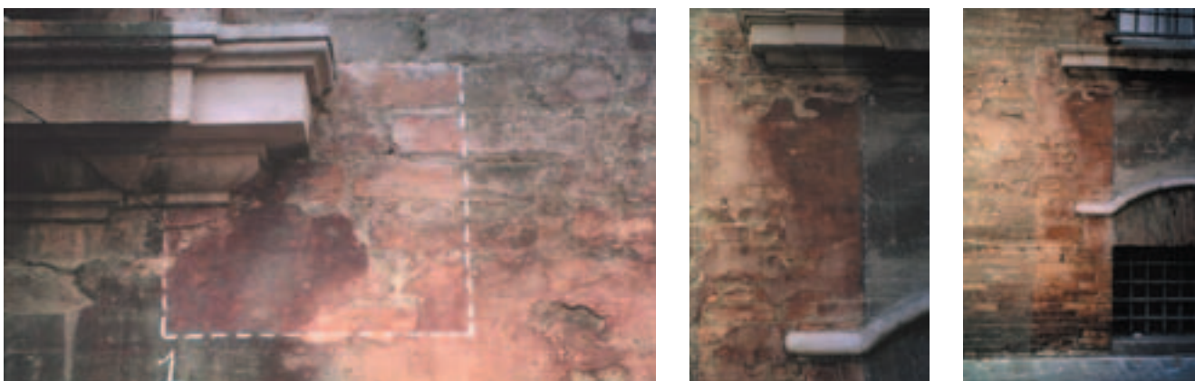
Campionature per la pulizia e il restauro della sagramatura e dei materiali lapidei
