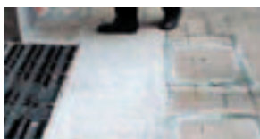
Dettaglio delle pavimentazioni dei cortili prima dei lavori
