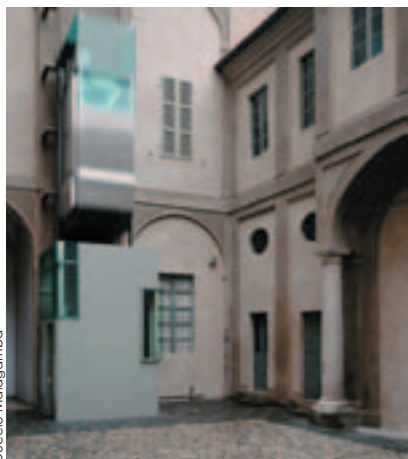
Cortile secondario: inserimento del nuovo ascensore
