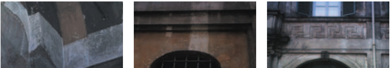
Campionature delle stratigrafie per il restauro delle facciate dei cortili interni
