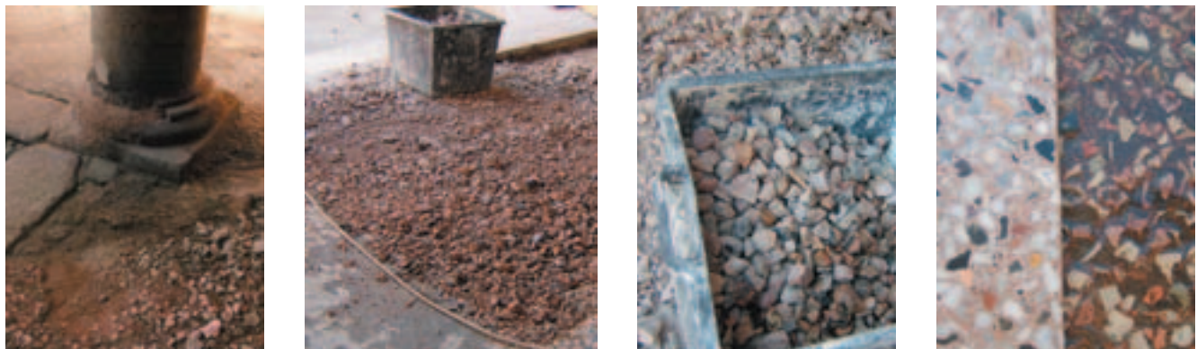
Fasi del recupero del pavimento dei porticati in seminato alla veneziana
