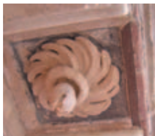
Dettaglio del rosone sottogronda
