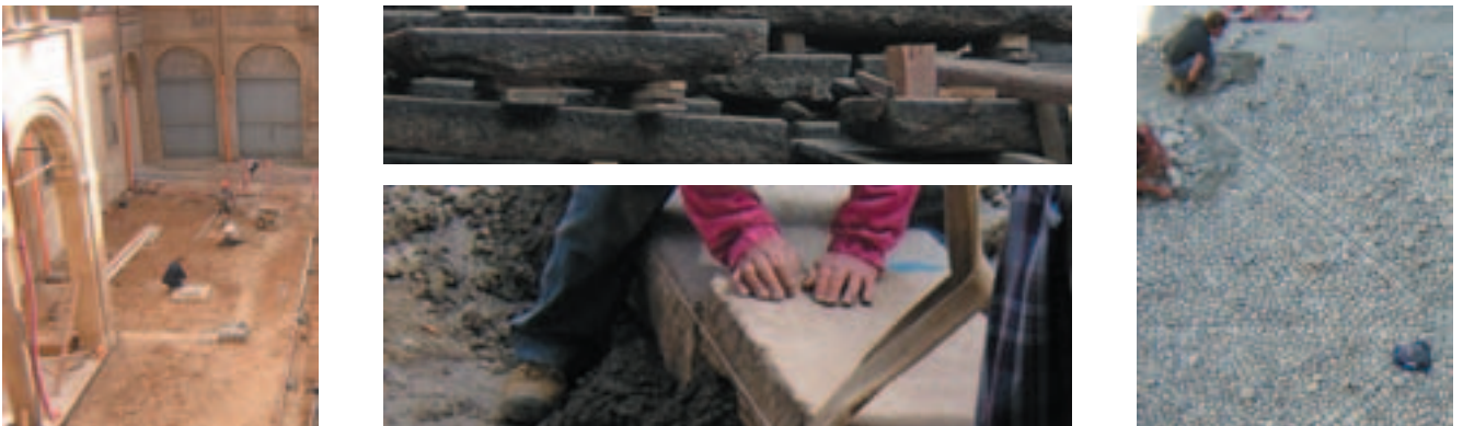
Rifacimento della pavimentazione del cortile principale con il recupero delle trottatoie originarie
