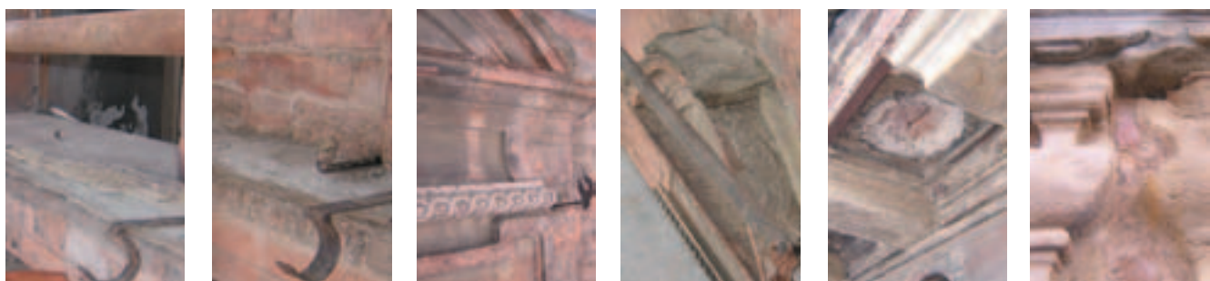
Campionature degli interventi di pulizia e restauro delle facciate
