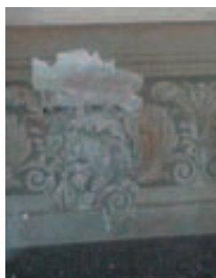
Campionature stratigrafiche delle fasce decorate: recupero degli affreschi settecenteschi ancora presenti sotto le successive e recenti decorazioni a tempera
