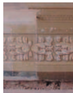
Campionature stratigrafiche delle fasce decorate: recupero degli affreschi settecenteschi ancora presenti sotto le successive e recenti decorazioni a tempera
