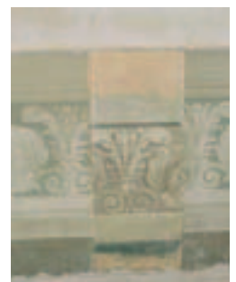
Campionature stratigrafiche delle fasce decorate: recupero degli affreschi settecenteschi ancora presenti sotto le successive e recenti decorazioni a tempera
