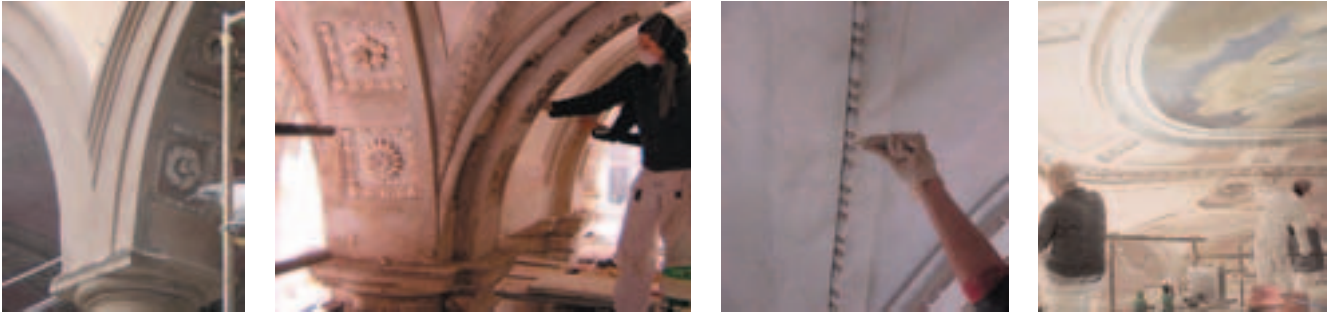
Fasi del restauro delle volte di loggiati e scalone
