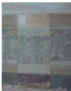
Campionature stratigrafiche delle fasce decorate: recupero degli affreschi settecenteschi ancora presenti sotto le successive e recenti decorazioni a tempera
